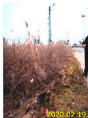
Vasúti ájtjáró felé eső sarok
