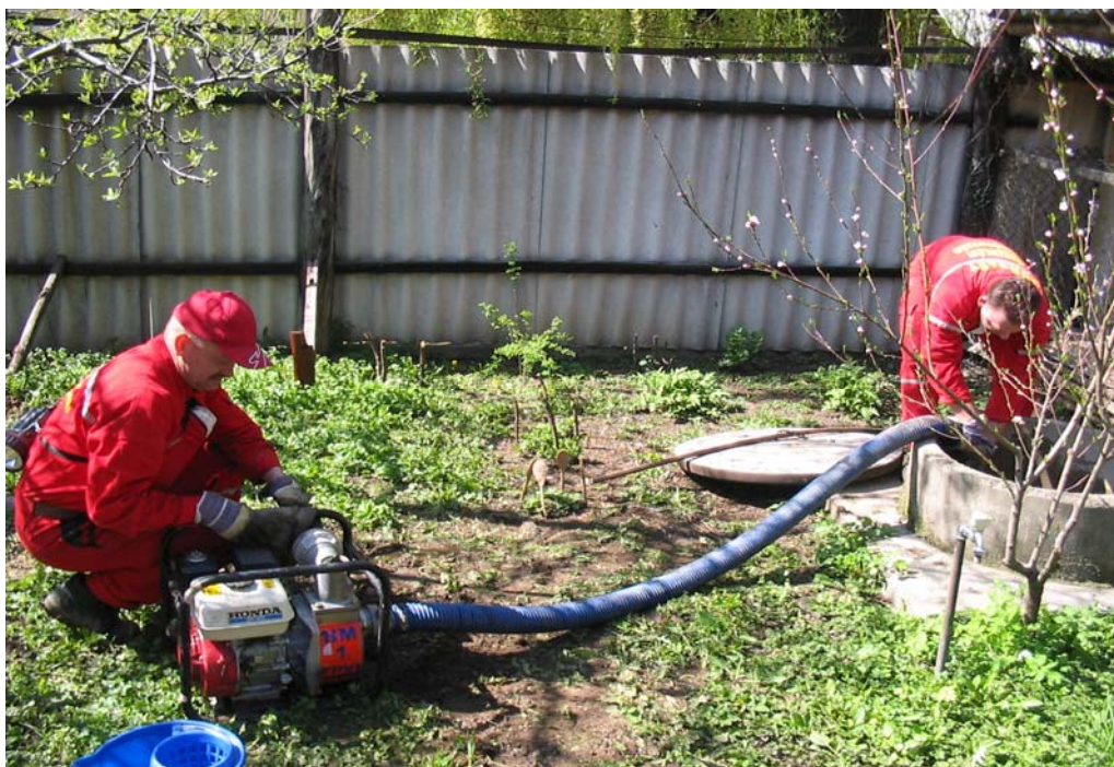
Ivóvíz kutak tisztítása Mátrakeresztesen
